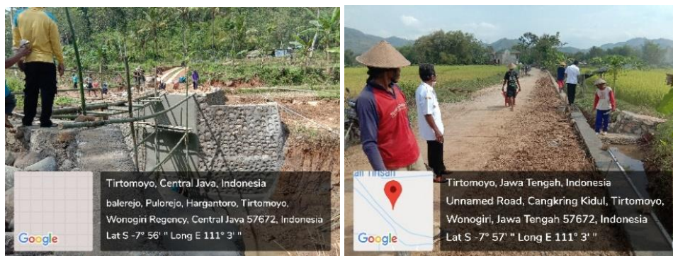
Gambar 5. Penilaian realisasi kegiatan pembangunan jembatan dan drainase desa
